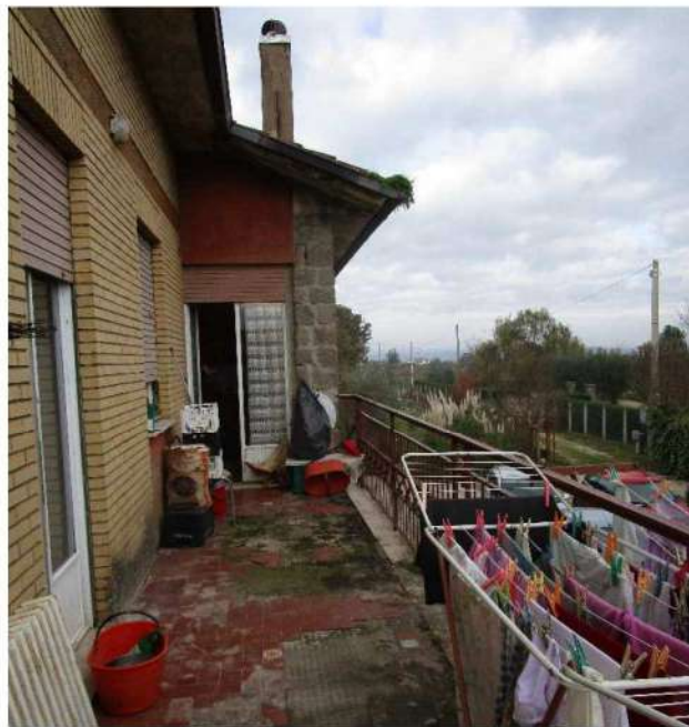
Figura 28: Balcone piano primo
