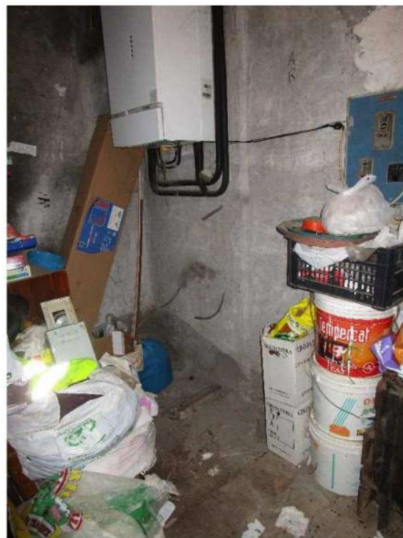
Figura 11: Vano tecnico piano terra
