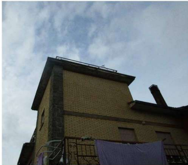
Figura 2: Particolare rivestimento in cortina di mattoni
