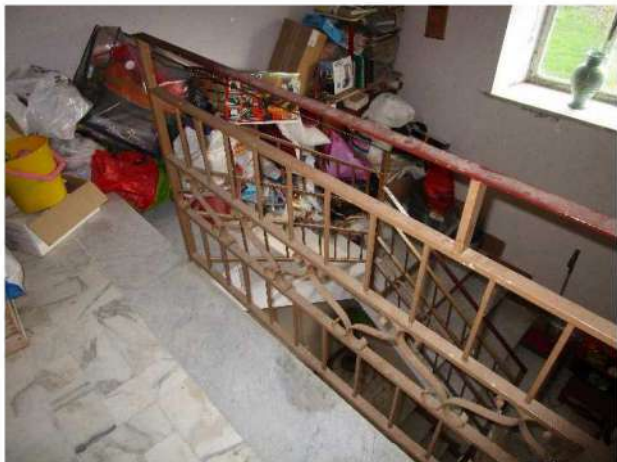
Figura 37: Rampa di accesso al piano sottotetto
