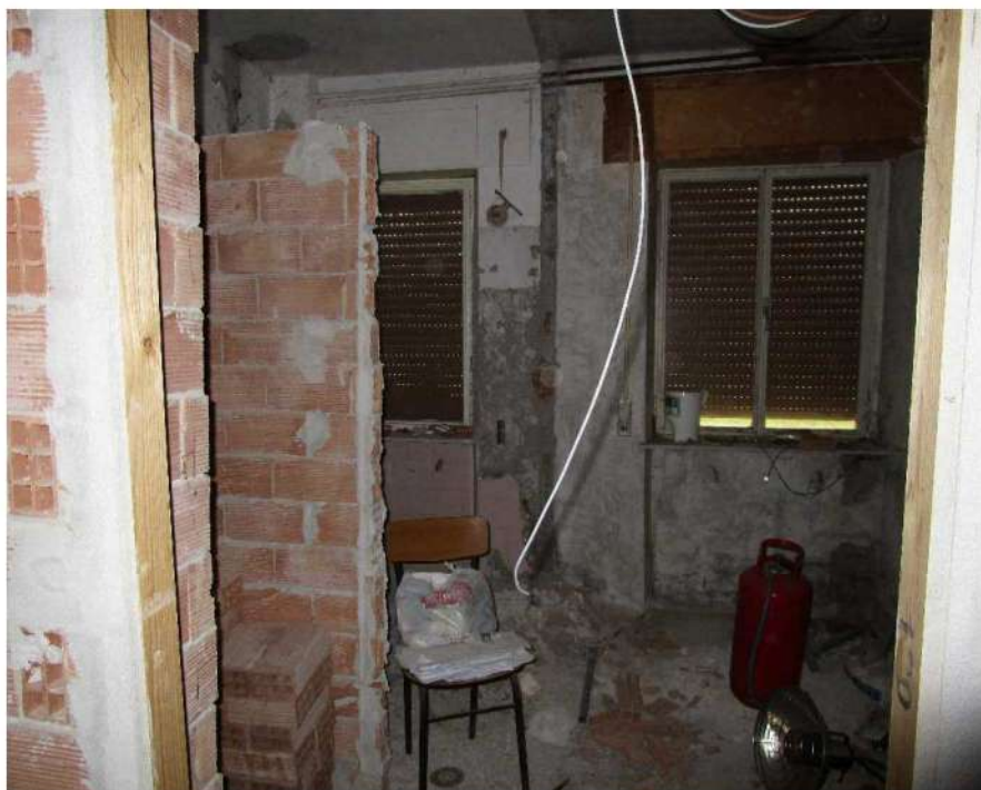
Figura 16: Bagno piano terra
