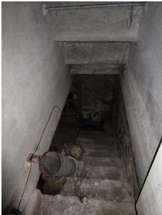
Figura 6: Ingresso piano seminterrato/cantina
