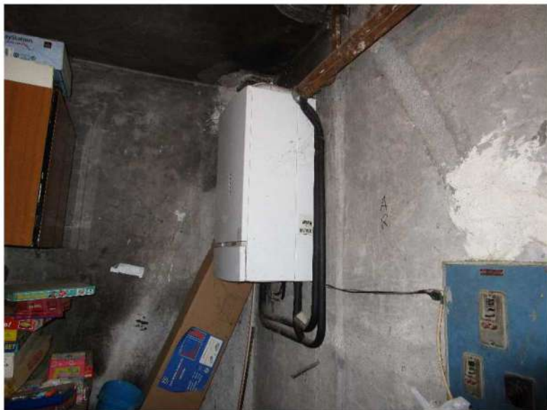
Figura 10: Vano tecnico piano terra
