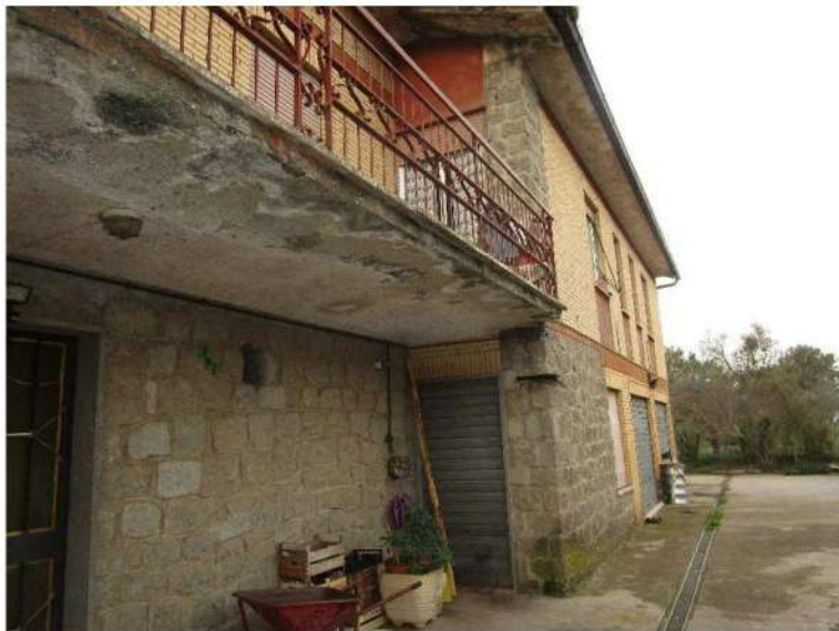
Figura 1: Vista ingresso principale al piano terra
